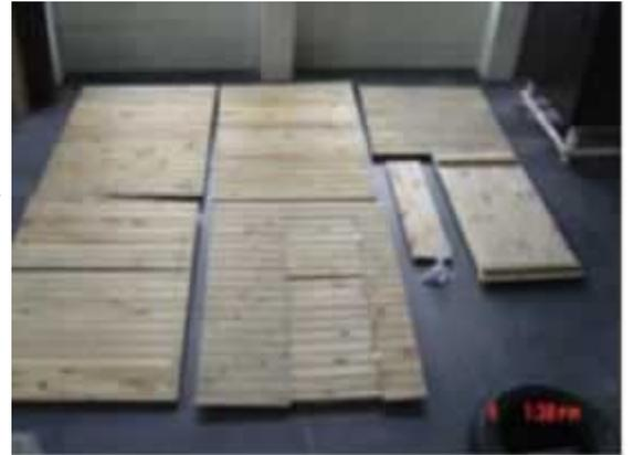
Bitte legen Sie den mitgelieferten Kanzelboden ( Siehe **Abb. 2**) auf das Bockgerüst. Sie werden feststellen, das Bockgerüst, Terrasse, der Kanzelboden und die Kanzel selbst exakt miteinander abgestimmt sind. Bitte vernageln Sie die mitgelieferten 36 Nägel 90mm gleichmäßig verteilt Bohlen und den darunter auf den in die Bohlen und den darunter liegenden Rahmen des des Kanzel - Bocks.
