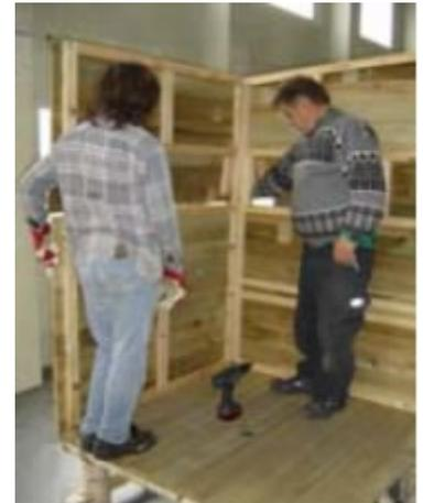
Sichern Sie jetzt die beiden aufgestellten Teile, Front und rechtes Seitenteil. Stellen Sie das linke Seitenteil mit dem Holzrahmen auf den Kanzelboden. Das unterste Brett steht 3 cm über den Kanzelboden hinaus und liegt parallel an. Rücken Sie das linke Seitenelement an den Holzrahmen der Frontseite heran (Siehe **Abb. 7** )Bitte verschrauben Sie die beiden Metallwinkel oben und unten mit dem Seitenteil. Bitte verwenden Sie die Schraubengröße 3,2 x 35 mm.
