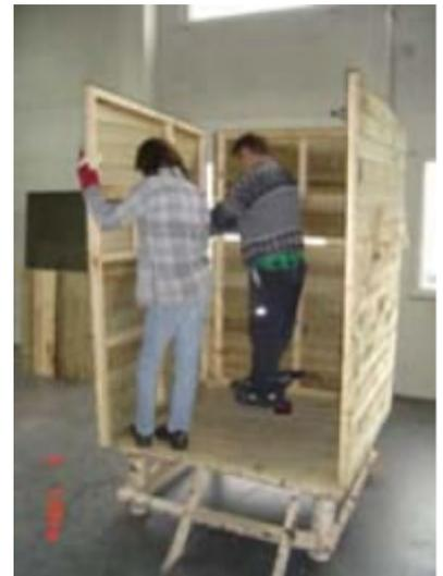
Bitte montieren Sie die verbleibenden vier Metallwinkel auf dem Dachlattenrahmen des Türelement. Bitte sehen Sie sich vor dem Anschrauben ( Siehe **Abb. 4** )die Lage der Winkel an. Bitte stellen Sie das Türelement mit dem Dachlattenrahmen auf den Kanzelboden . Verwenden Sie bitte die Schrauben 3,2x35 mm .
